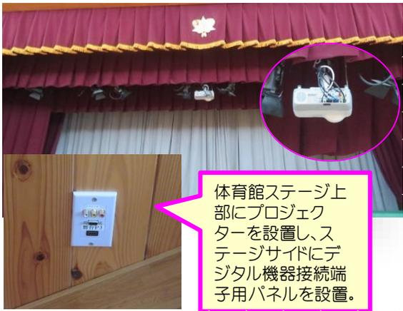
体育館ステージ上部にプロジェクターを設置し、ステージサイドにデジタル機器接続端子用パネルを設置。
